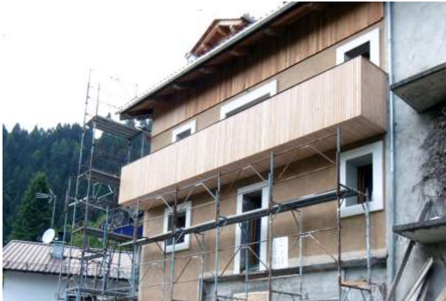
Viste esterne preesistente e di cantiere
