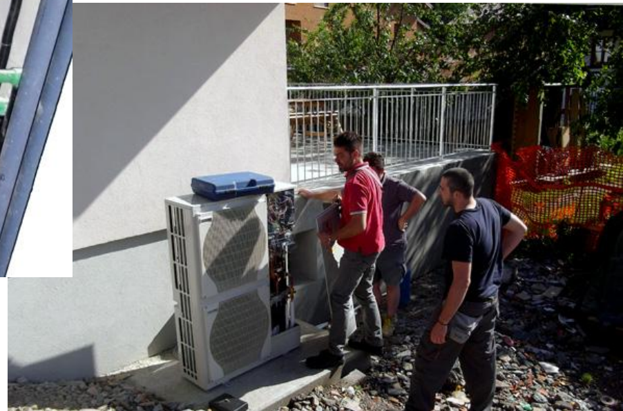
Pompa di calore aria-aria e collettori VMC
