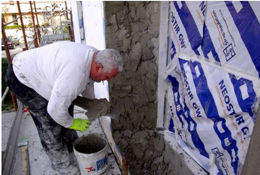
Intonacatura termoisolante strombature
