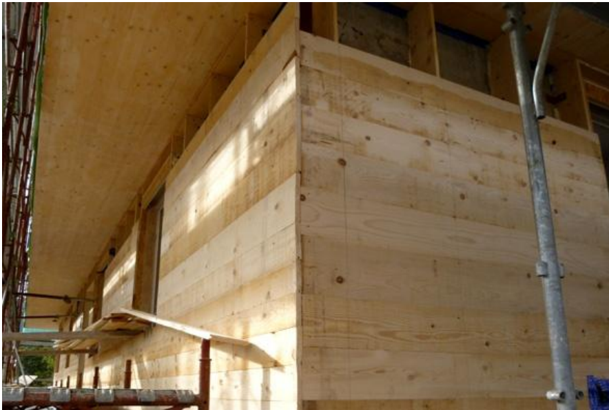
Realizzazione casseri lignei sulle murature
