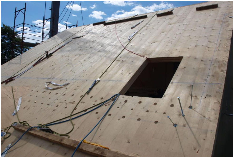
Pannelli di copertura in X-lam con fissaggi
