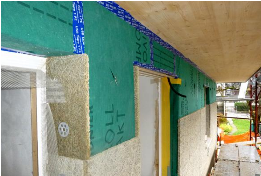
Applicazione pannelli porta intonaco su telo
