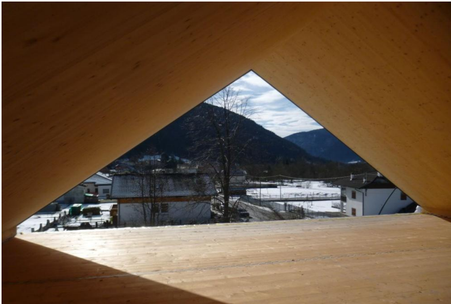
Copertura X-lam a vista con isolamento esterno
